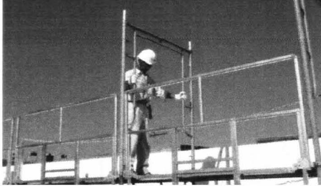
①最上段の足場を解体していきます。（最上段にはカルガルガードのみが残ります。）
