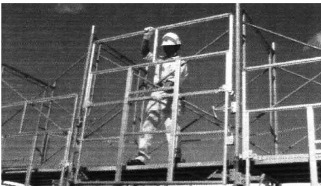
③足下の建枠横架材に可動フックが腰掛ける位置まで解除バーを操作し手を持ち替えながら、本体を下げます。
