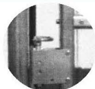
②下部を押ししたまま建枠に沿って90°回転します。
